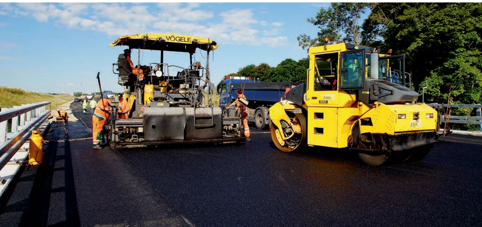
Membran og brobelægning i Asfalt
