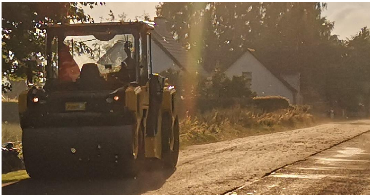
Fig. 6.1: Komprimering af BSM in-situ – "Grøn", bæredygtig belægning i grønne omgivelser.
