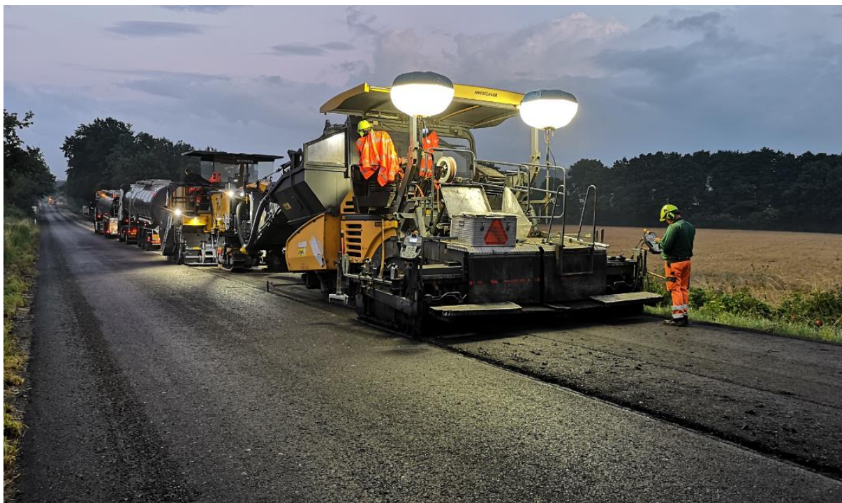
Fig. 4.3: BSM in-situ udlægningstoget i fuld gang på Ørbækvej. Arbejdet blev udført som natarbejde ultimo juni, hvor der kun er ganske kort tid mørkt.
