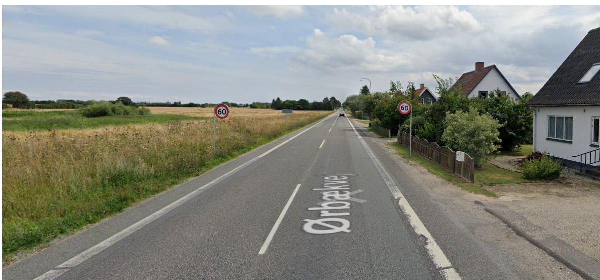
Fig. 3.2: Ørbækvej-strækningen før reovering, set fra nordlige del mod syd (Kilde:Google maps 2019)
